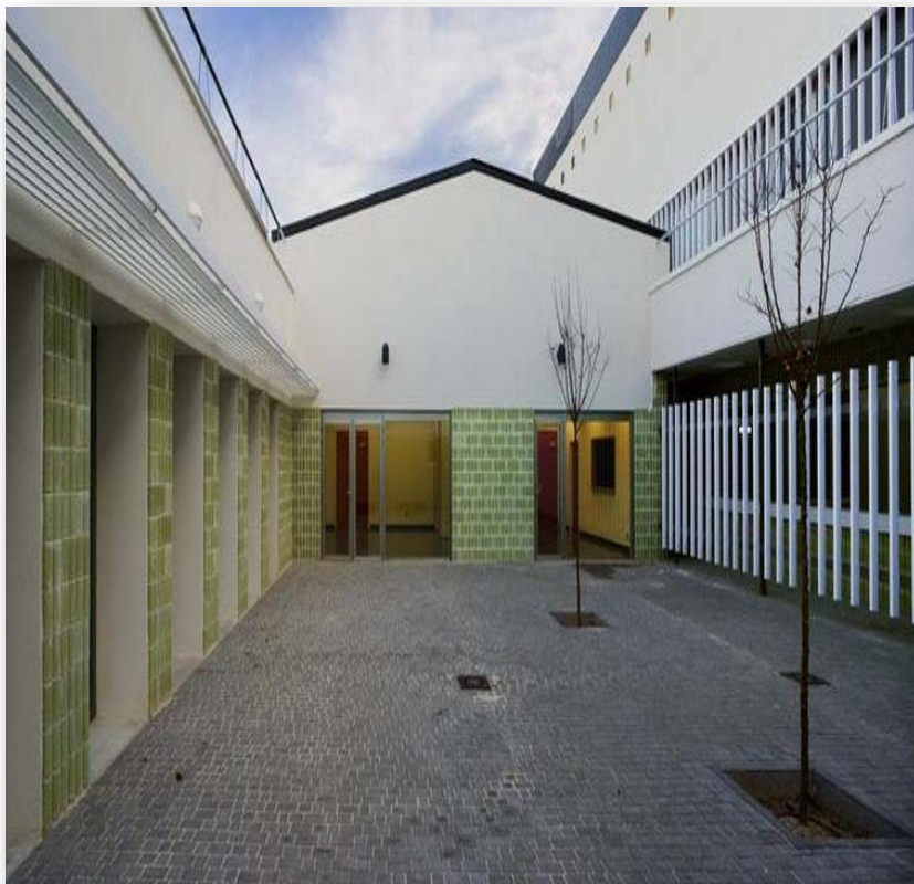
Patio interior CAID Vallecas.
