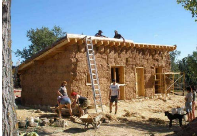
Figura 34. Proceso previo al revoco
