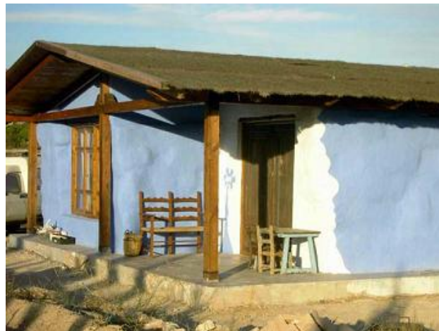
Figura 35. Casa terminada con estructura de madera
