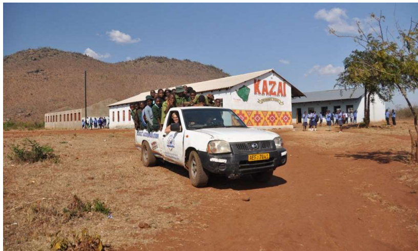
Ilustración 4: Edificio del colegio de formación profesional ya construido.
