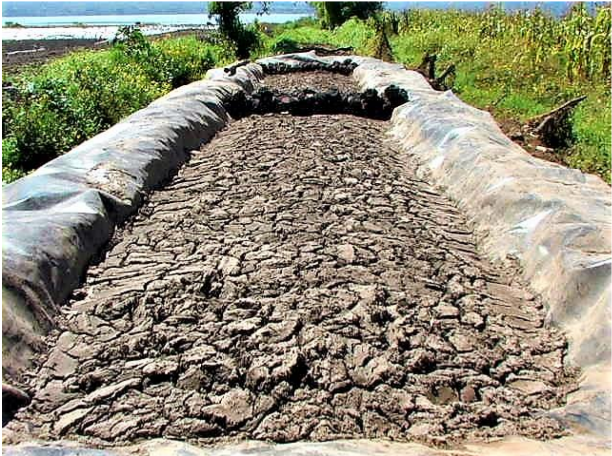
Figura 27: Lecho de secado de lodos. Fuente: Sustainable Sanitation and Management
