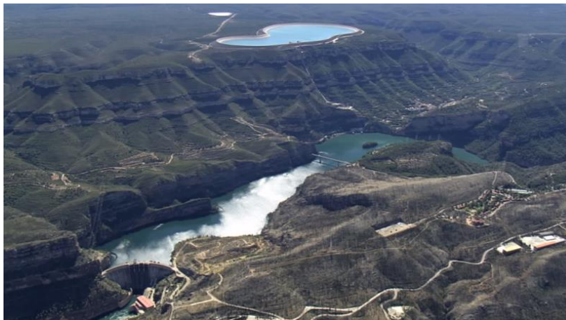
Figura 2-2. Central de bombeo Cortes la Muela. Fuente: https://elperiodicodelaenergia.com/las-10-mayores-centrales-hidroelectricas-de-bombeo-del-mundo/ .
