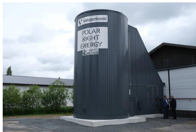
Figura 2-9. Silo de almacenamiento térmico en arena. Fuente: https://forococheselectricos.com/2022/07/bateria-arena-economica-sostenible.html
