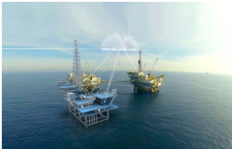
Ilustración 6: Plataforma petrolífera y una representación de su gemelo digital
