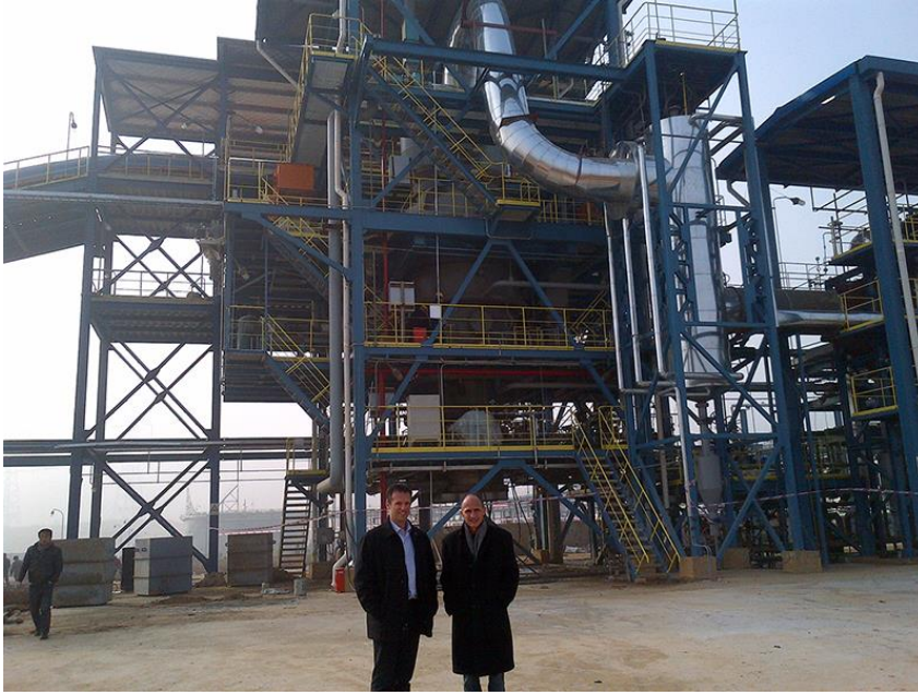
Figura 7. Planta de Wuhan Kaidi en construcción.[7]
