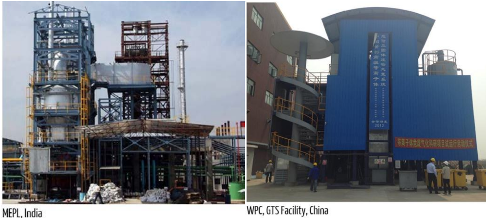
Figura 26. Plantas de gasificación por plasma instaladas en India (izquierda) y China (derecha) [24]
