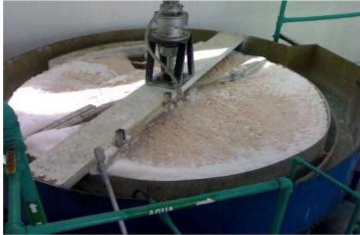
Figura 32. Digestión aerobia de lodos
