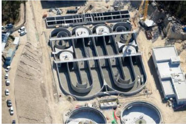
Figura 23. Eliminación de nitrógeno por Nitrificación-Desnitrificación
