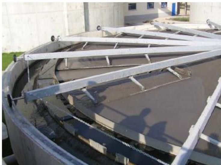
Figura 29. Espesamiento de lodos por gravedad
