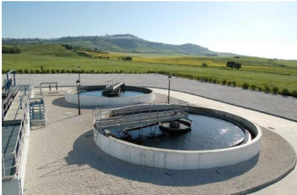
Figura 15. Decantador primario
