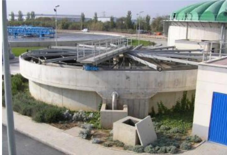
Figura 30. Espesamiento de lodos por flotación
