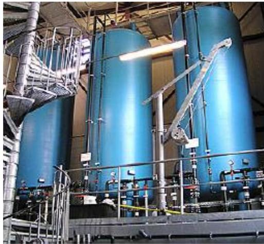
Figura 25. Columnas de adsorción sobre carbón activo
