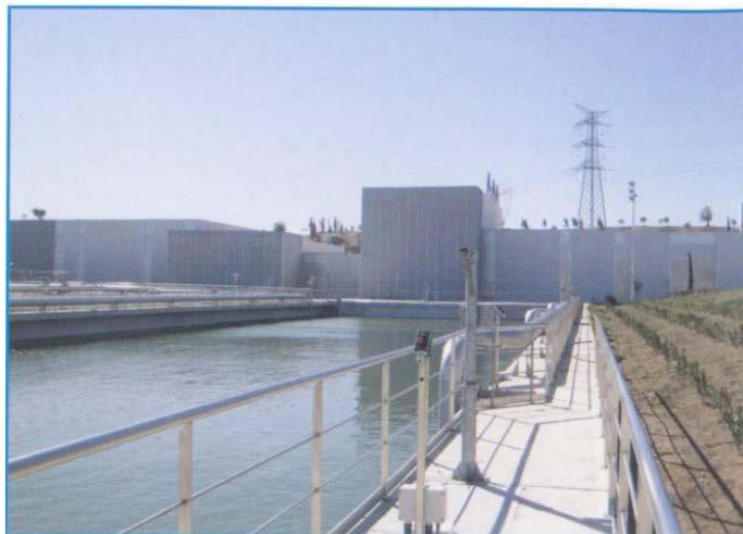
Figura 14. Balsa de homogeneización
