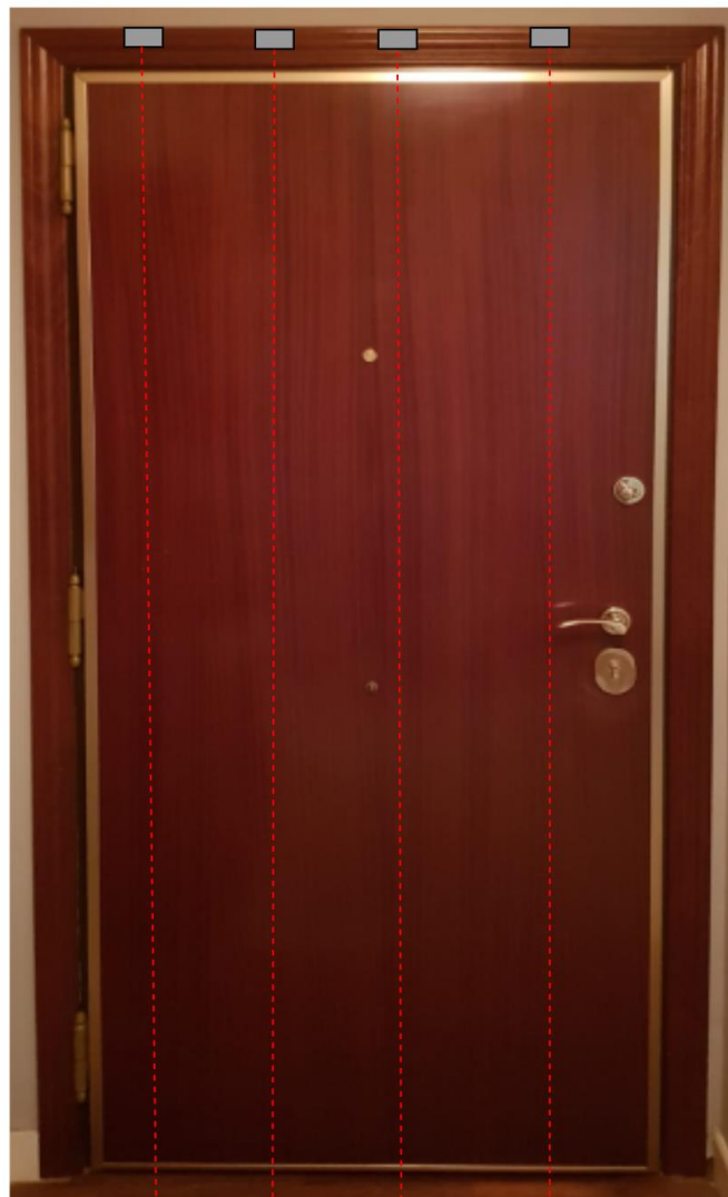
Figura 22. Ejemplo instalación de sensores de tiempo de vuelo en una puerta real (Fuente: elaboración propia)
