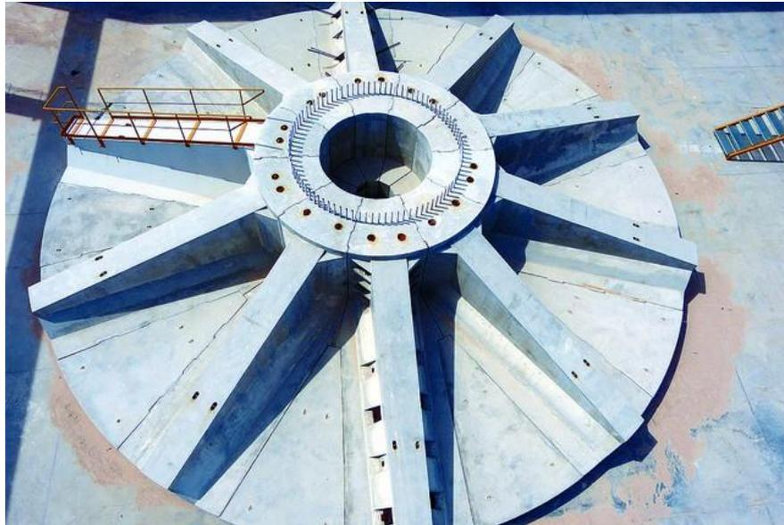
*Figura 36. Cimentación de contrafuertes*
