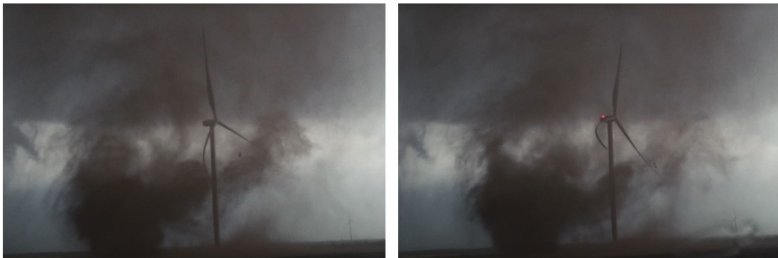
Figure 1: Desviación de las palas de un aerogenerador bajo la influencia de una tormenta. Figura extraída de la referencia [1].
