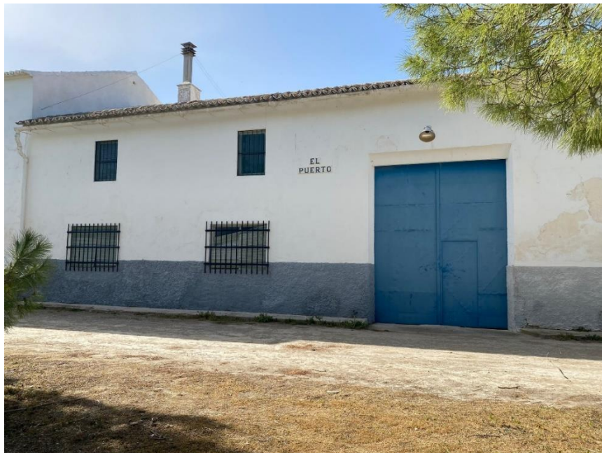
Ilustración 8: Fachada Cortijo "El Puerto". Fuente: elaboración propia (2023).
