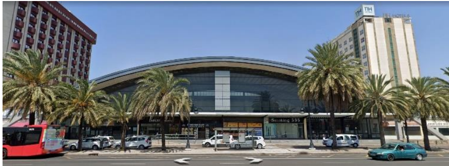
Ilustración 19. Vista frontal estación autobuses Valencia.
