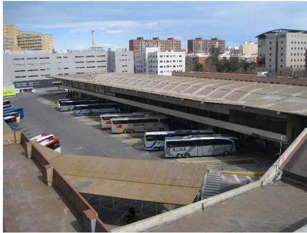
Ilustración 21. Vista lateral porche central contrachapado.
